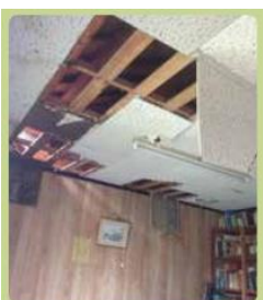
民家屋根裏に営巣した蜂の巣を狙いに侵入したツキノワグマが踏み抜いた天井
